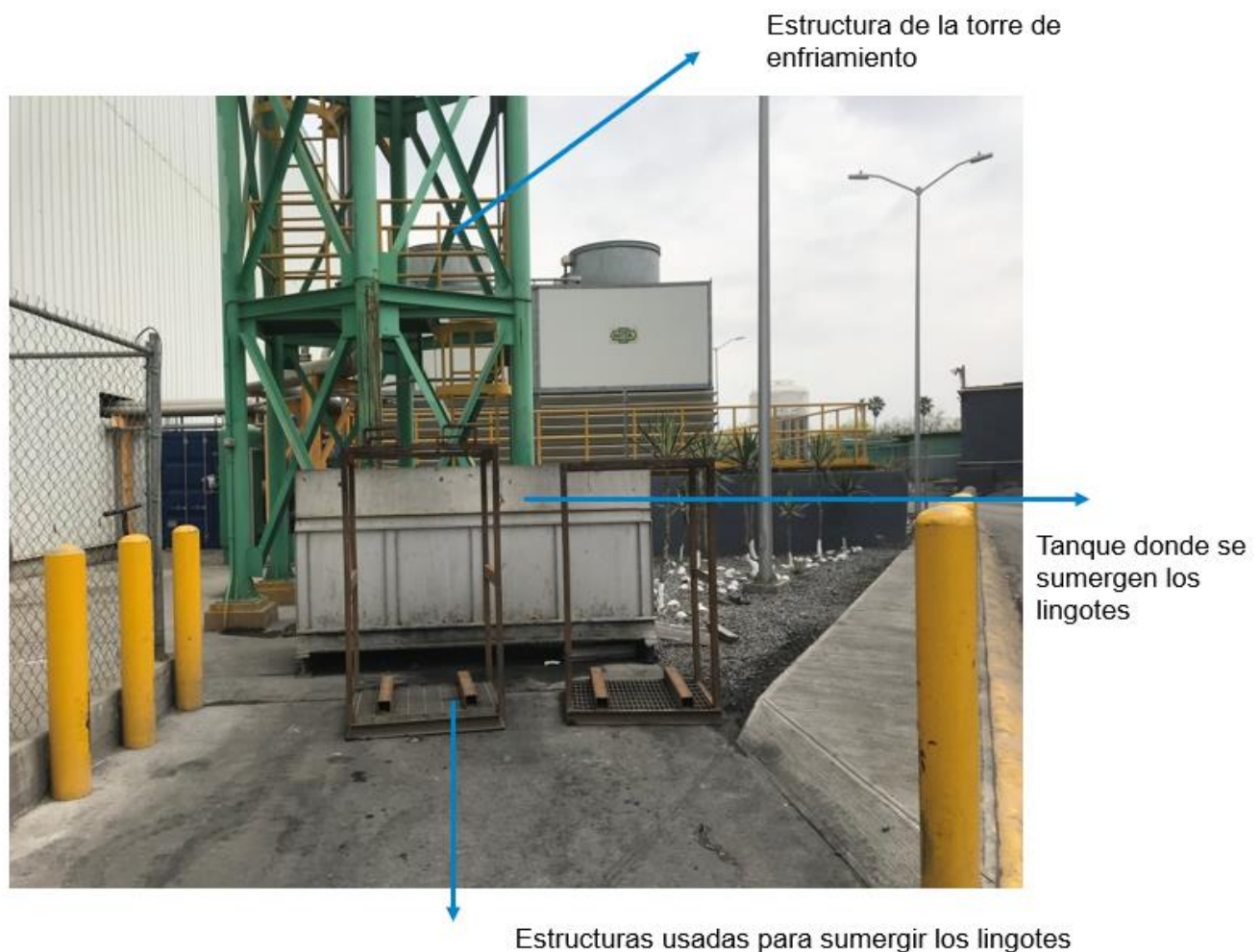
Figura II.29 Infraestructura de torre de enfriamiento (recirculación de agua)
