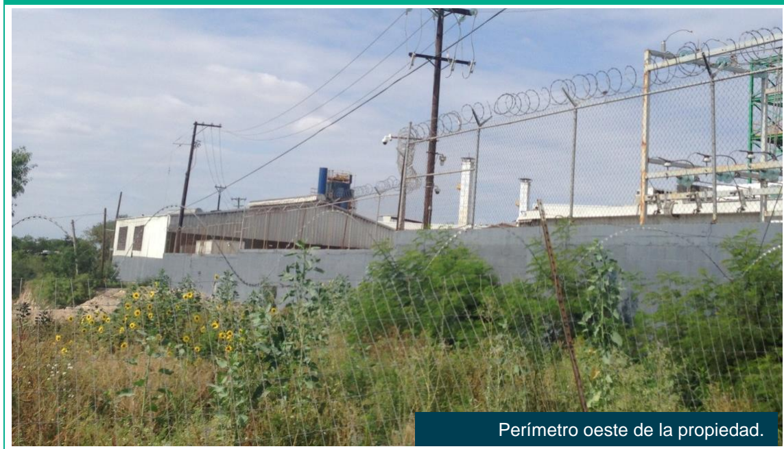
Figura IV.17 Vista colindancia oeste
