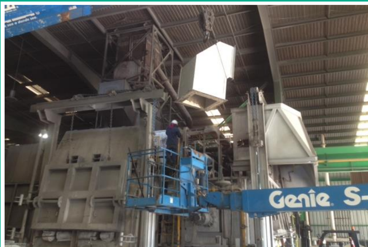
Figura II.25 Instalación de ductos de transferencia
