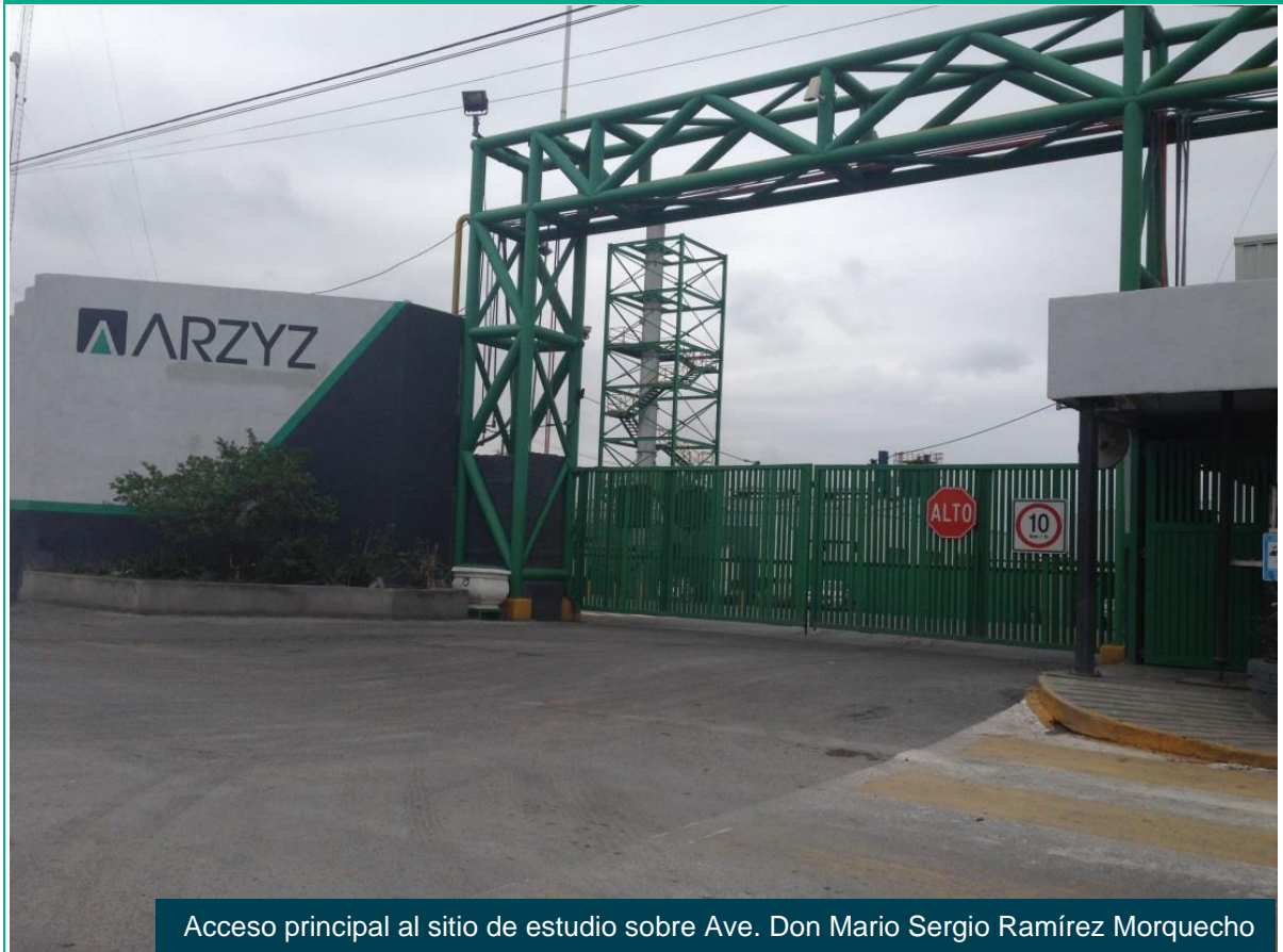
Figura IV.21 Instalaciones del sitio de estudio
