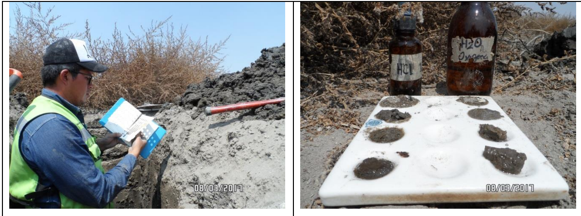
Figura IV—63. Barrenación y construcción de perfil para la descripción del suelo presente en el área del proyecto de la planta termovalorizadora.
