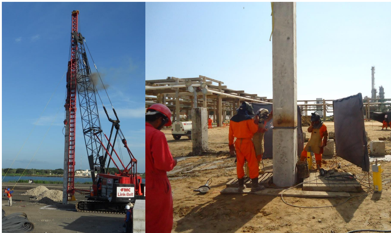
Figura II—94. Hincado y unión de sección de pilote.
