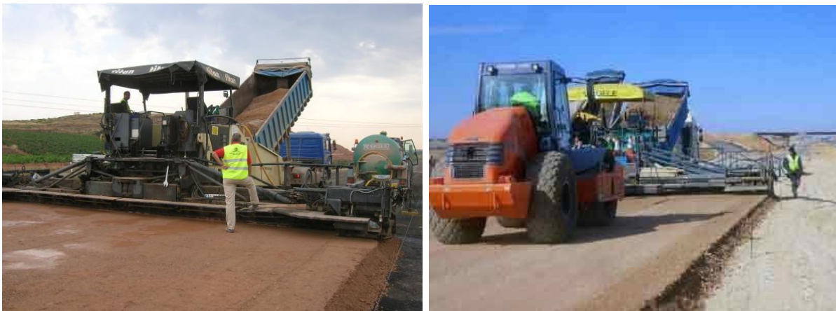
Figura II—105. Ejemplo de la colocación de la base estabilizadora.
