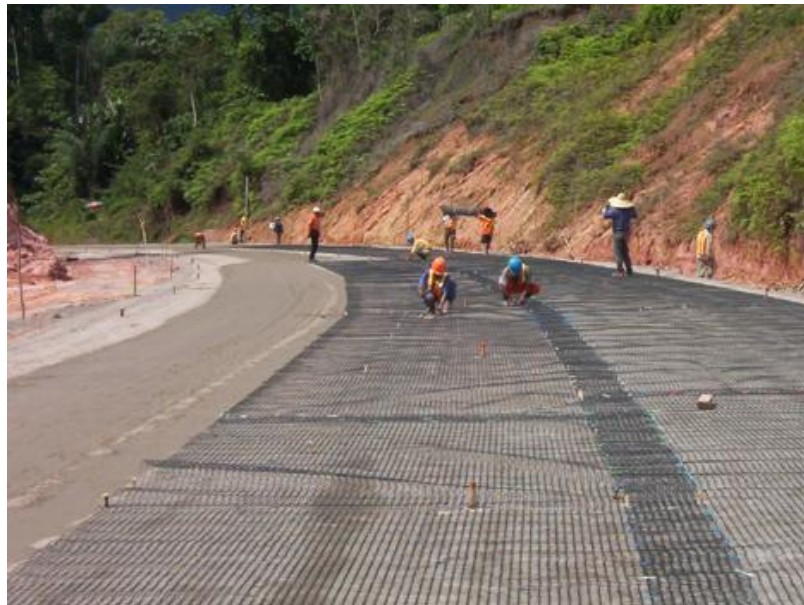
Figura II—103. Colocación de la capa subbase.
