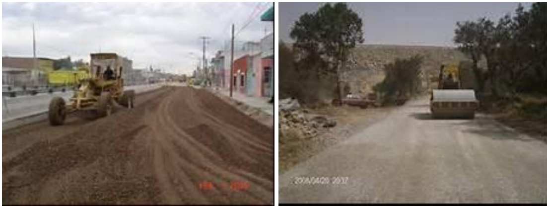
Figura II—104. Ejemplo del proceso de compactación de la capa subbase.
