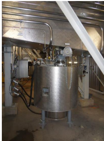
Figura II—57. Transporte neumático al silo de residuos.
