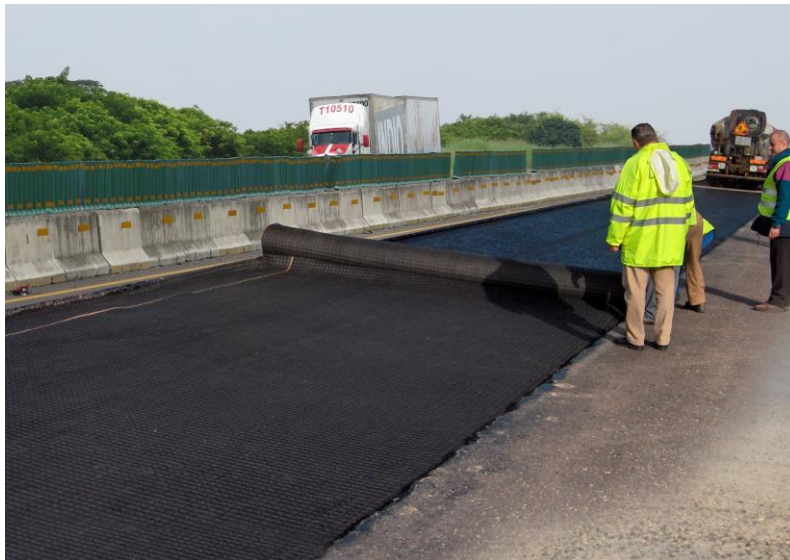
Figura II—102. Ejemplo de la colocación de las geomallas.
