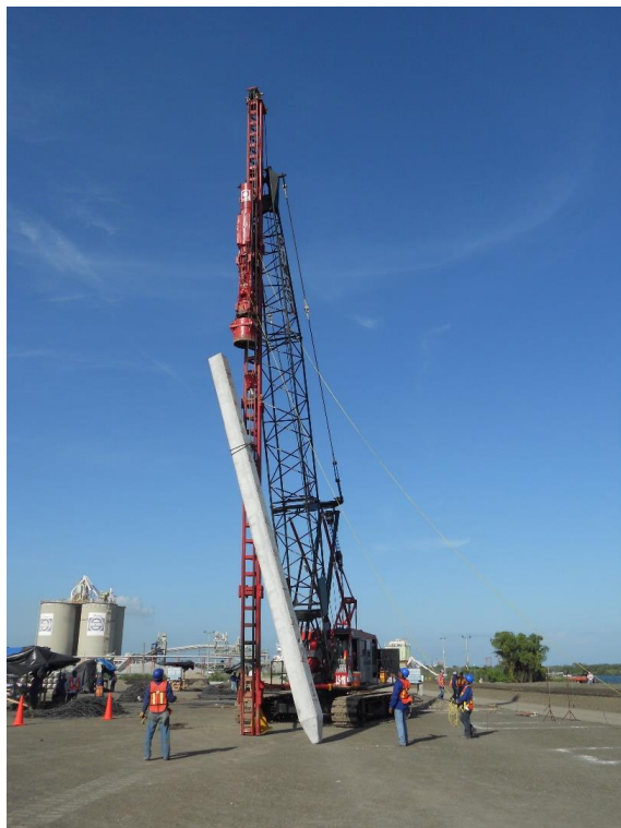
Figura II—93. Izaje e introducción de pilote.
