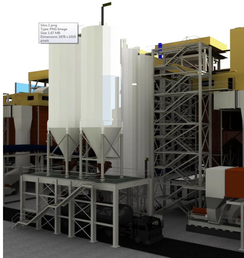
Figura II—71. Silos de almacenamiento de residuos.
