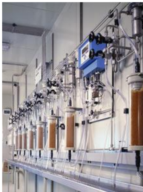
Figura II—47. Estación de toma de muestras.
