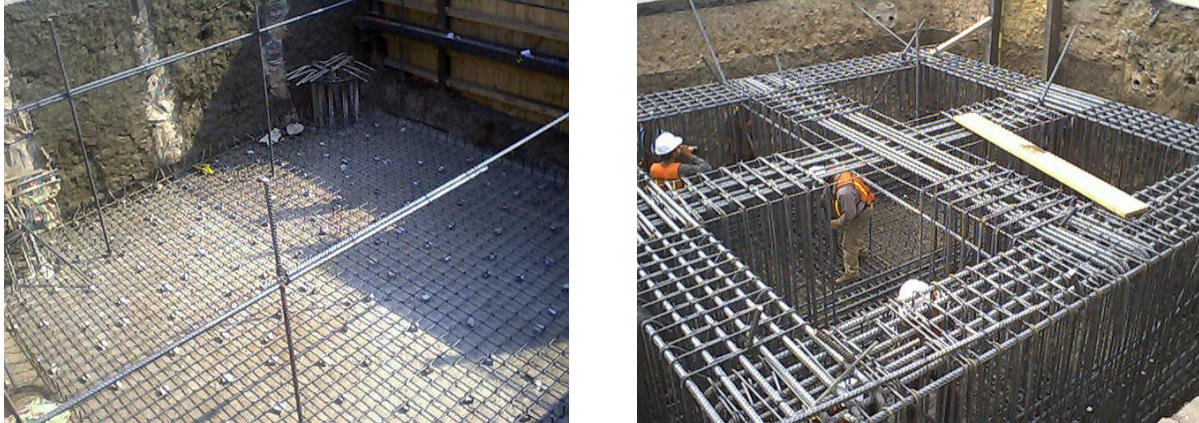
Figura II—96. Cimentación superficial y armado de zapatas.
