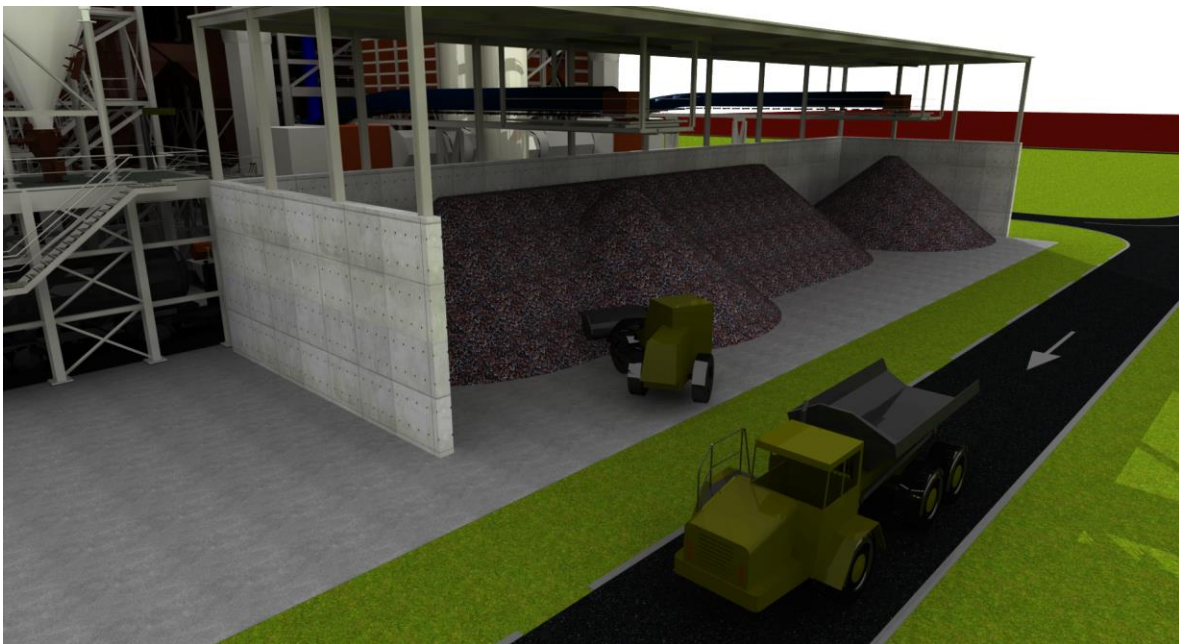
Figura II—42. Zona de almacenamiento de escorias.
