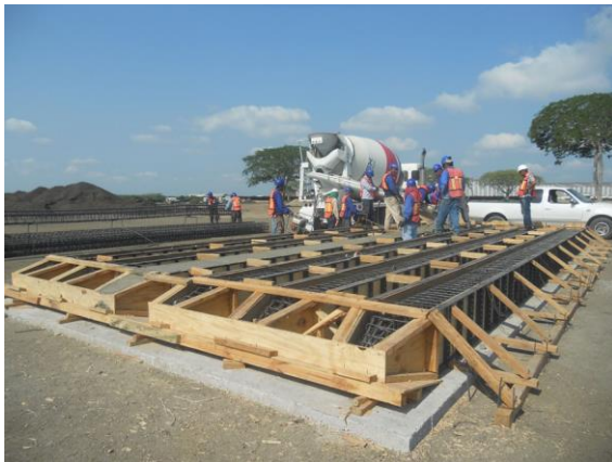
Figura II—90. Colado y pilote producido.
