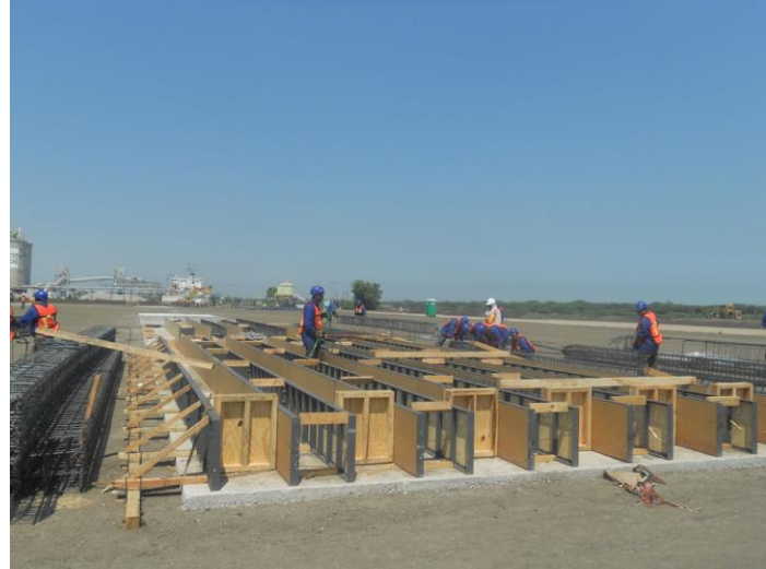
Figura II—89. Armado y cimbrado de pilote.
