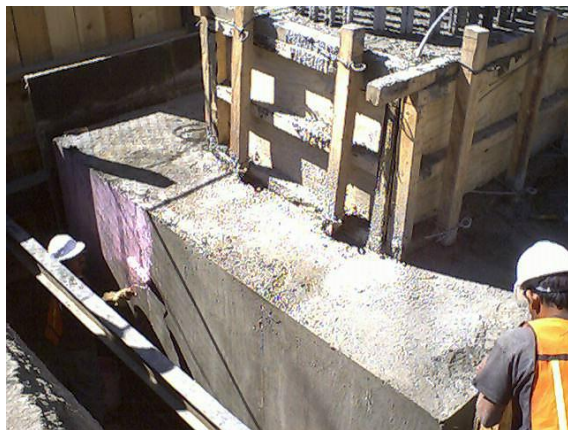
Figura II—97. Zapatas coladas en sitio.
