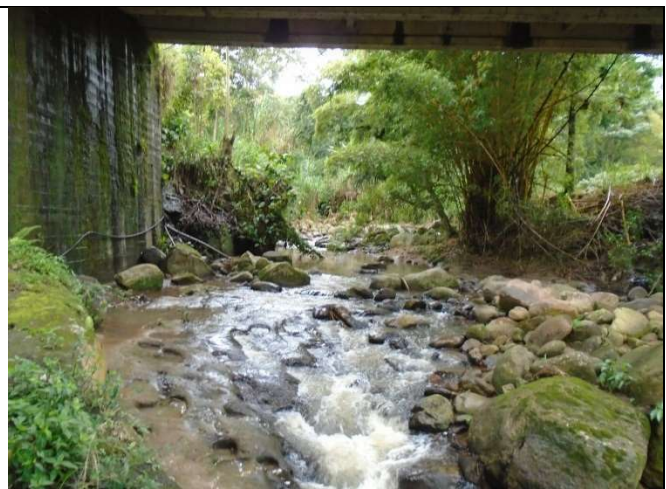
Fotografía 14 Quebrada los Guayabos- ID14
