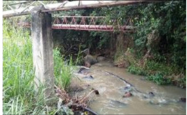
Fotografía 4 Quebrada Seca aguas arriba intervención
