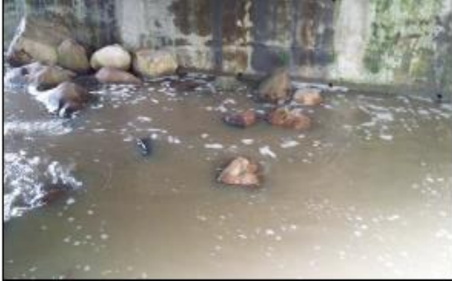
Fotografía 3 Quebrada Seca aguas arriba intervención
