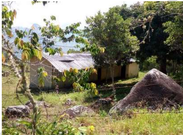
Fotografía 14 Infraestructura Escuela Tokio
