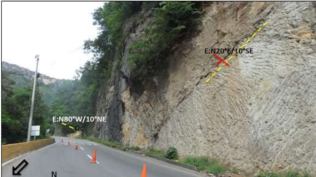
Fotografía 24 Portal Entrada Túnel Palmichala. Areniscas cuarcíticas, la estratificación presenta buzamientos al SE. Foto tomada en sector La Cañada.
