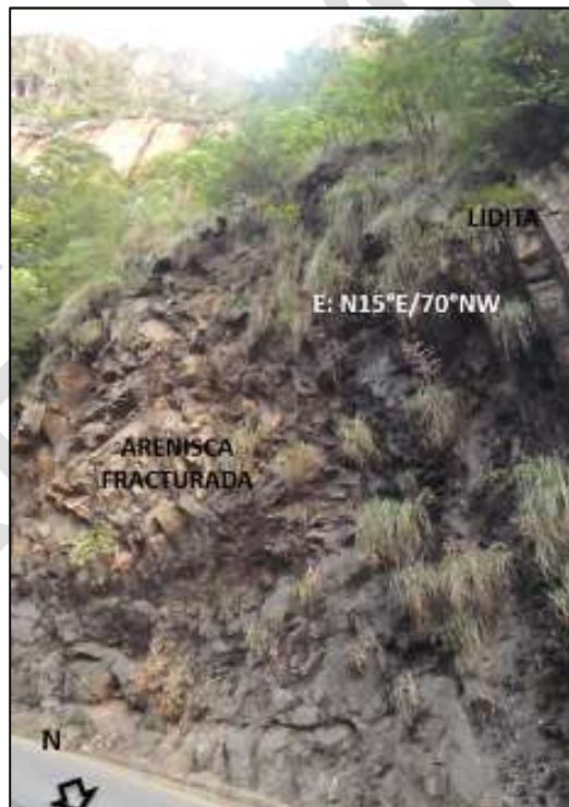
Fotografía 22 Túnel Divino Niño. Niveles de areniscas y liditas fracturadas con alto buzamiento al Norte.
