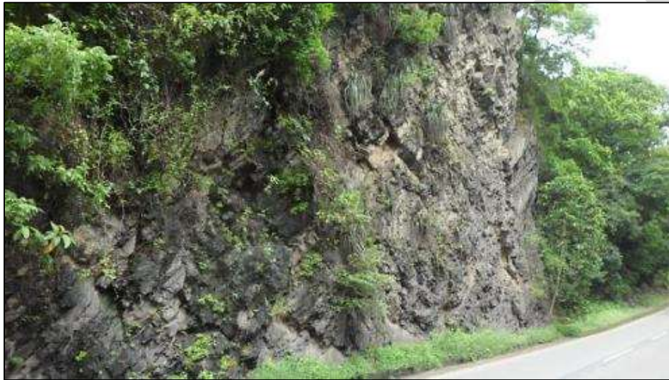
Fotografía 31 Túnel Nariz del Diablo. Secuencia de Lidita muy fracturada
