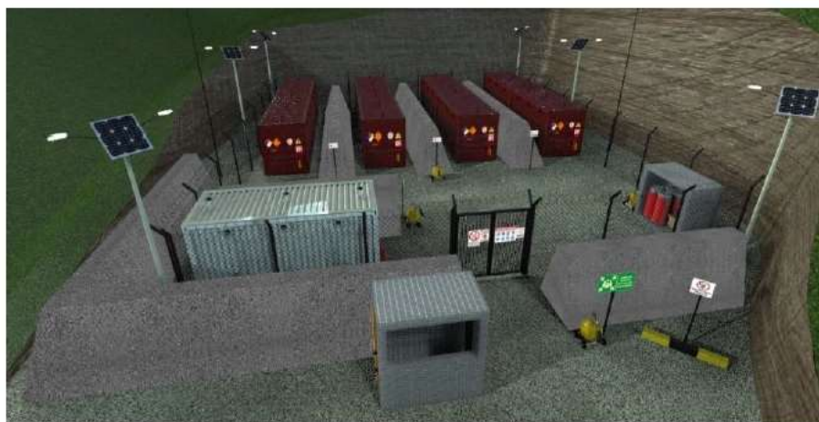
Figura 27. Ejemplo De Una Zona De Almacenamiento De Explosivos En Colombia
