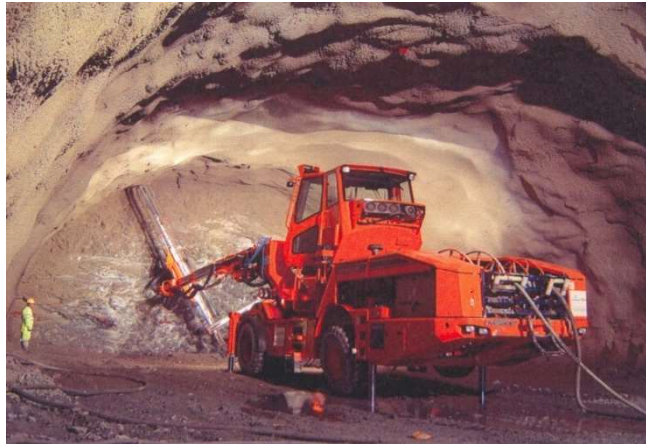
Figura 23. Bulonado del frente
