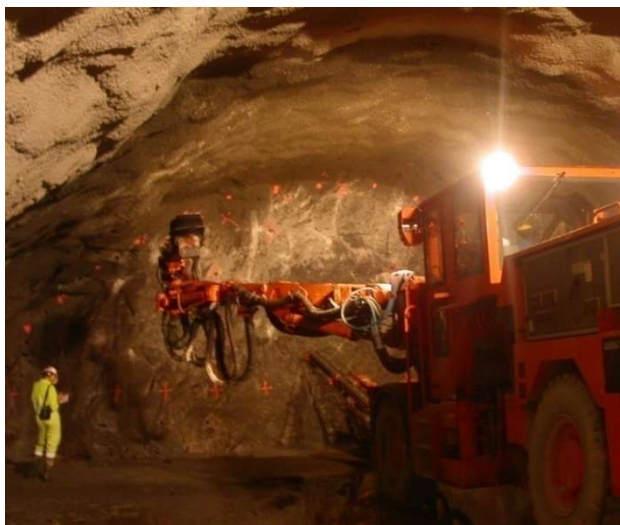
Figura 18. Perforación en el frente con jumbo
