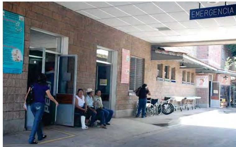
Fotografía 1.1 Hospital Nacional de Sonsonate
