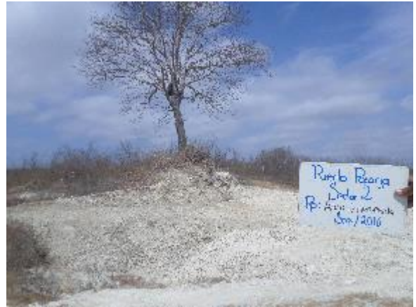
Fotografía.754424: Área intervenida cortes de terreno
