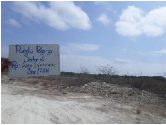
Fotografía.753423: Área intervenida cortes de suelo
