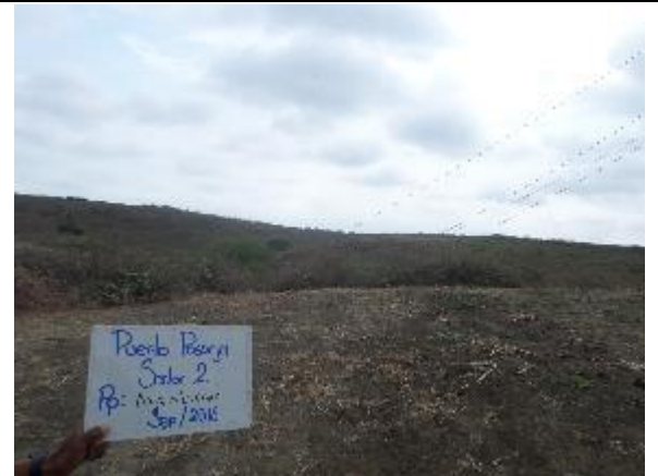
Fotografía.738408: Área intervenida cortes de suelo y rellenos
