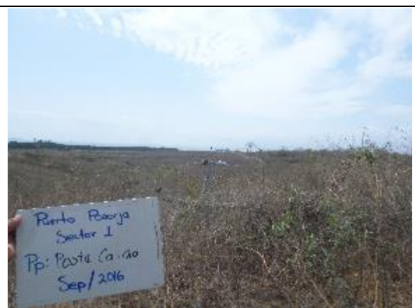
Fotografía.716386: Poste caído área de estudio no se realizan trabajos
