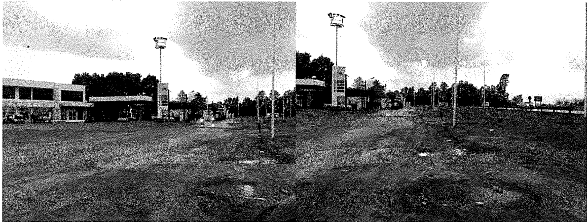
El frente de acceso a Carmen de Areco también muestra una actividad regular de atención en materia de servicios a nivel local y pasante. Vista del frente norte.
