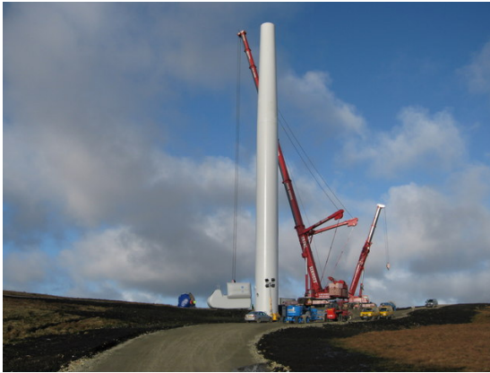
Foto 2.b-10: Içamento da Nacele em um parque eólico localizado no Reino Unido
