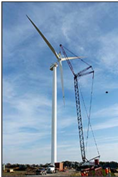
Foto 2.b-12: Montagem do Cubo do Rotor na Nacele em um parque eólico localizado no estado de Colorado, Estados Unidos
