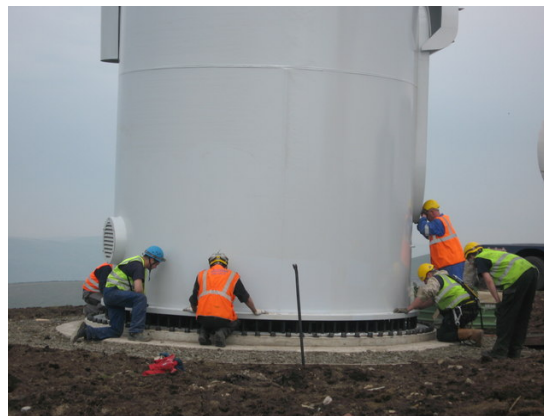
Foto 2.b-7: Instalação da Torre Base em um parque eólico localizado no Reino Unido
