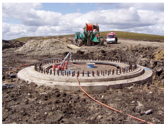
Foto 2.b-2: Base Concluída. Exemplo: Parque eólico Trairi
