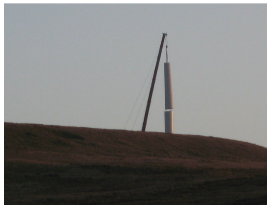
Foto 2.b-9: Montagem da Torre superior em um parque eólico localizado no Reino Unido
