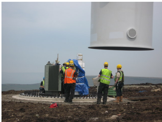
Foto 2.b-6: Instalação da Torre Base em um parque eólico localizado no Reino Unido
