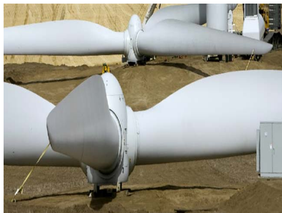
Foto 2.b-5: Pás acopladas no cubo do rotor.
