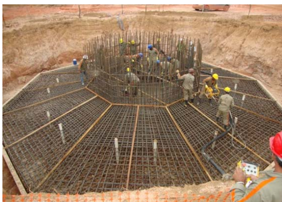
Foto 2.b-1: Montagem da Armação da Base. Exemplo: Parque Eólico Trairi
