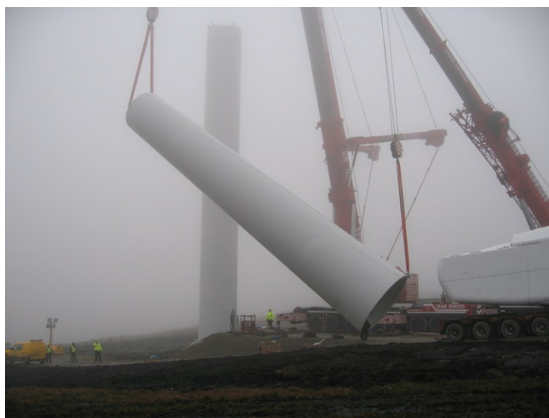
Foto 2.b-8: Montagem da Torre Superior em um parque eólico localizado no Reino Unido
