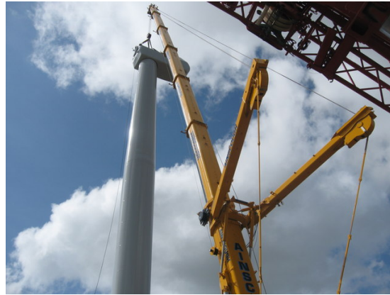
Foto 2.b-11: Acoplamento da Nacele em um parque eólico localizado no Reino Unido
