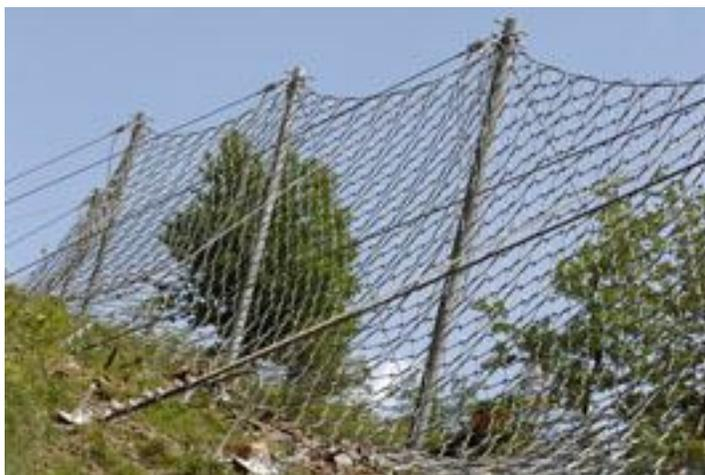
Figura 2. Malla de protección (tipo) contra derrumbes.
