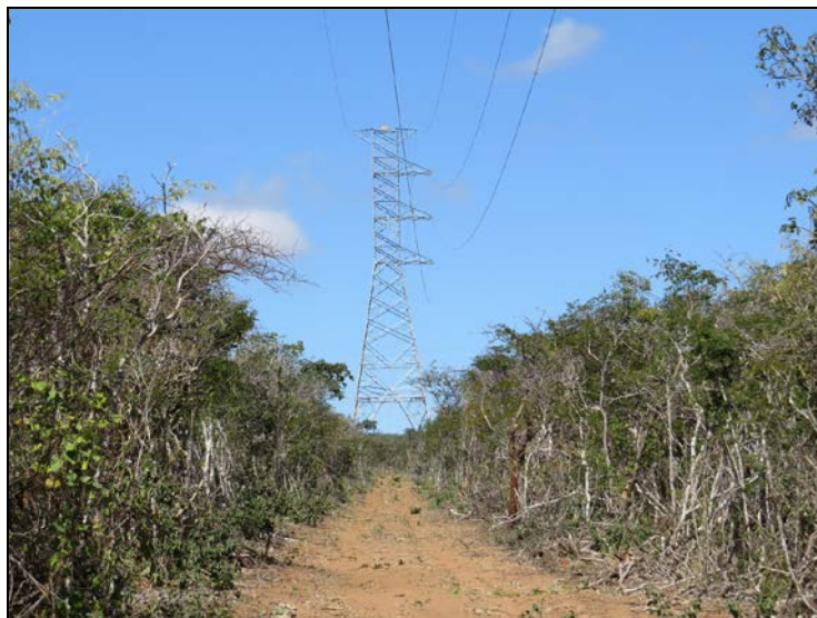
Figura 6.2.2-3 - Área da subestação (trecho final da LT 230 kV Serra da Babilônia - Morro do Chapéu II). LT Morro do Chapéu - Irecê em paralelismo. Detalhe da vegetação densa da área.
