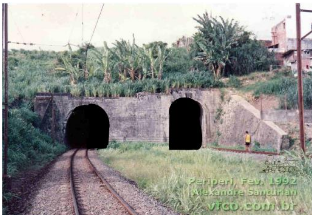
Vista frontal dos túneis do lado Estação Calçada
