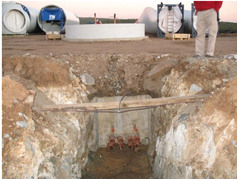
Figura 2.6. Canalización subterránea Parque Eólico Canela
