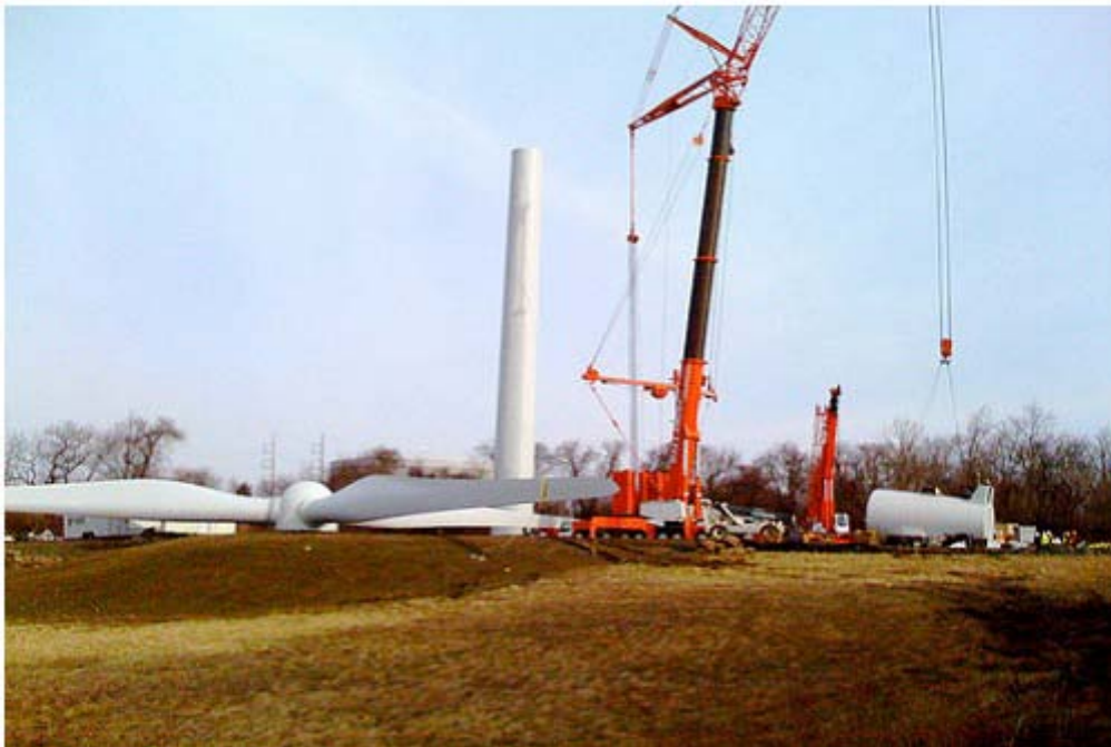
Figura 2.19. Patio de montaje de una turbina eólica
