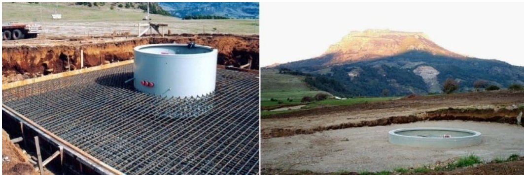
Figura 2.3. Fundaciones aerogenerador (Central Alto Baguales)
