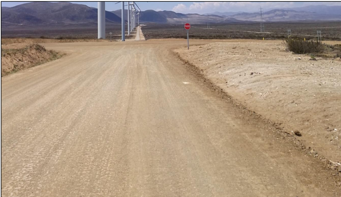
Figura 2-11. Camino interno del Parque Eólico Cabo Leones I, Región de Atacama.
