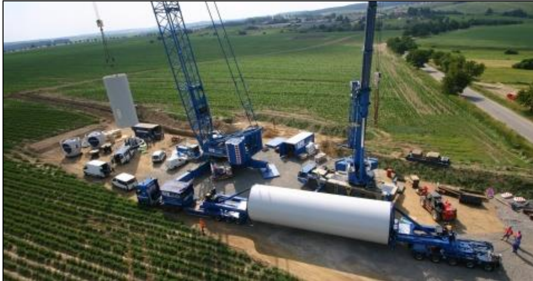
Figura 2-24. Plataforma de montaje de una turbina eólica.
