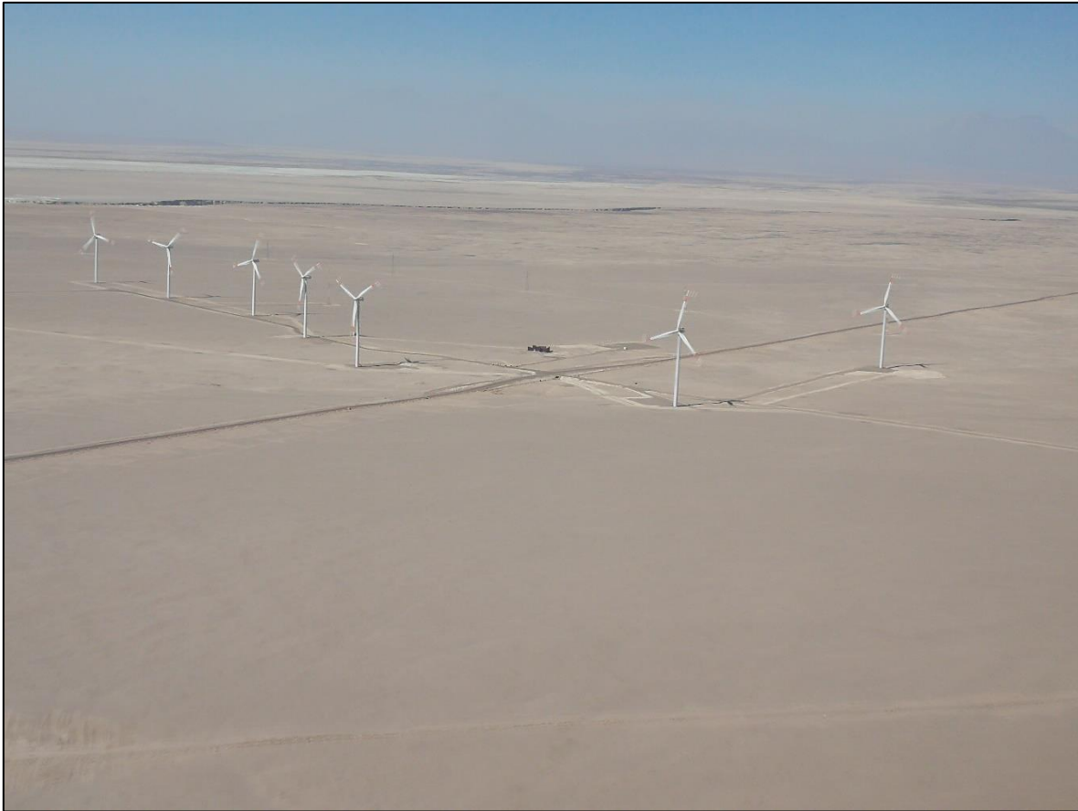
Figura 2-2. Vista aérea de una parte del Parque Eólico Valle de los Vientos.
