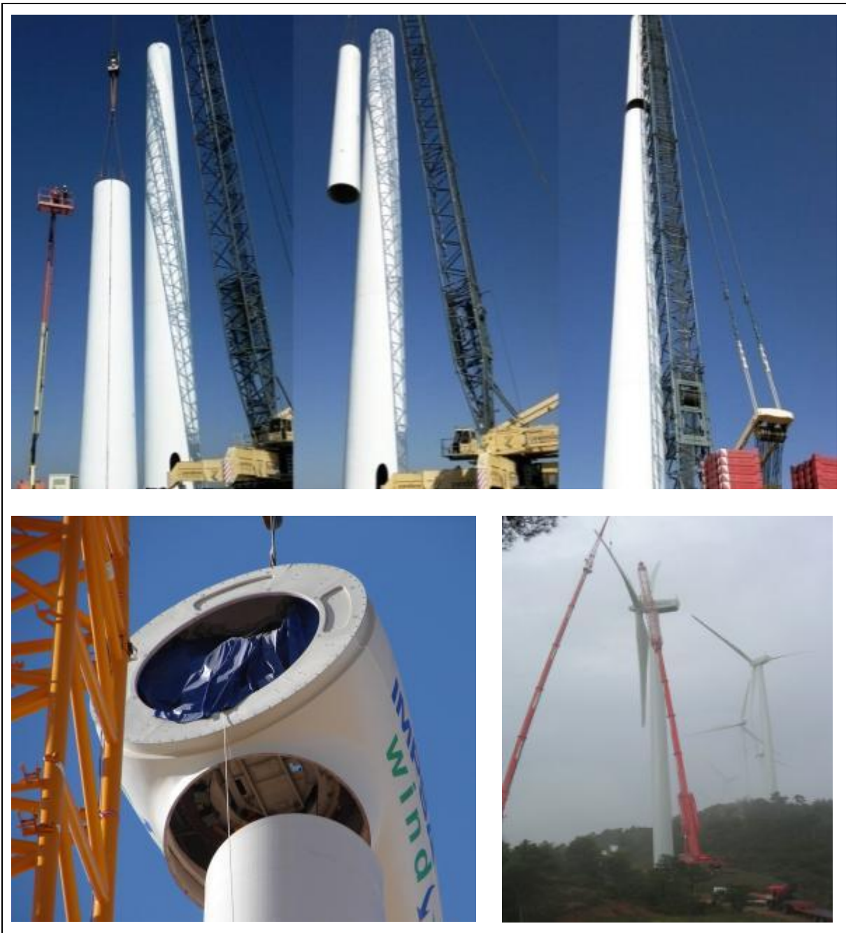
Figura 2-25. Secuencia de montaje de aerogenerador tipo.
