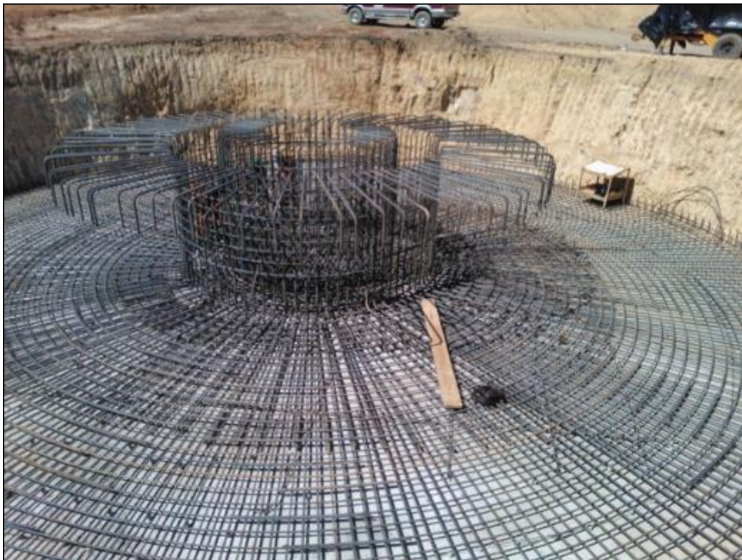
Figura 2-4. Armado de fundación de un aerogenerador.
