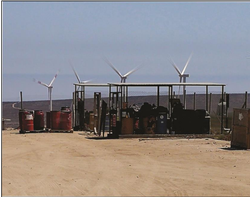
Figura 2-16. Fotografía Referencial Bodega de Residuos Peligrosos.
