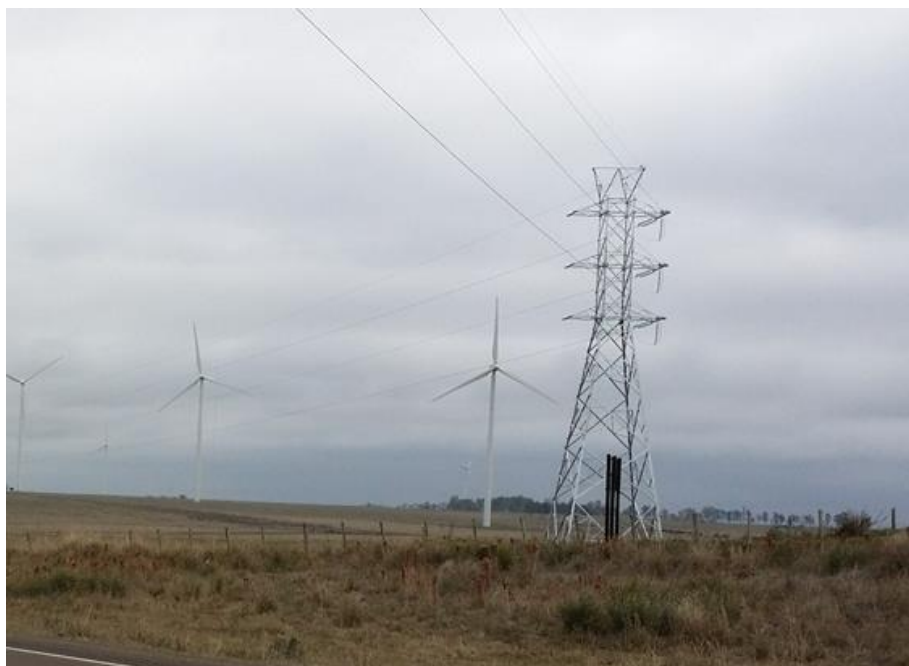
Figura 3-4: Fotografía de ejemplo de torre para línea de 150 kV
