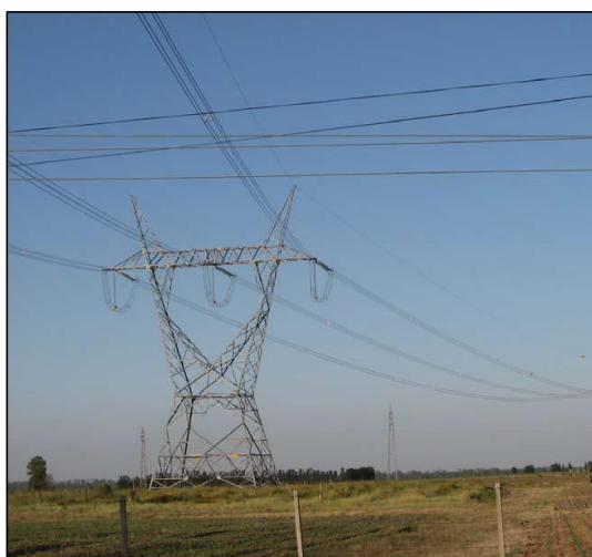
Figura 3-1: Torre autoportante para línea de 500 kV
