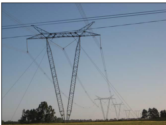
Figura 3-2: Torres con riendas arriostradas para línea de 500 kV
