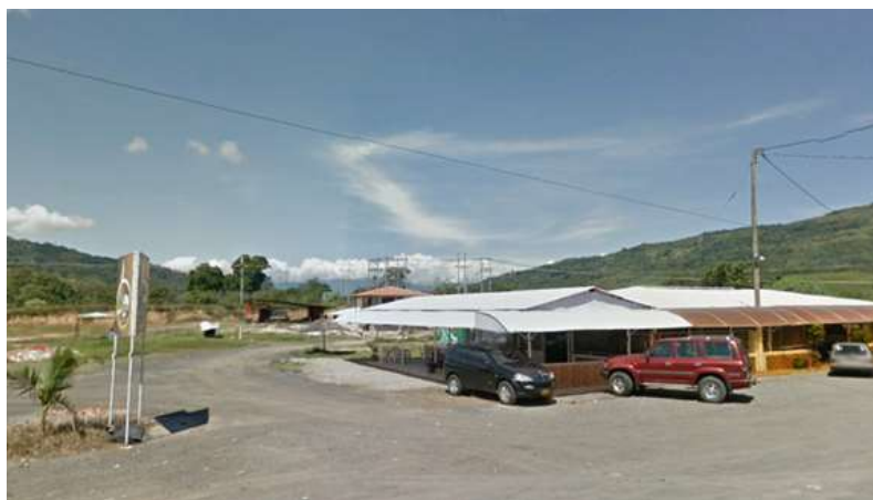
Fotografía 3.1 Zonas Industriales o comerciales (Subestación eléctrica Oiba, restaurante El Portal Oibano)
