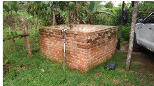
Fotografía 3.54 Sistema de almacenamiento de agua en el predio Villa Sara en la vereda Peñuela de Oiba
