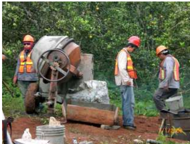
Fotografía 7.16 Mezcladora de concreto
