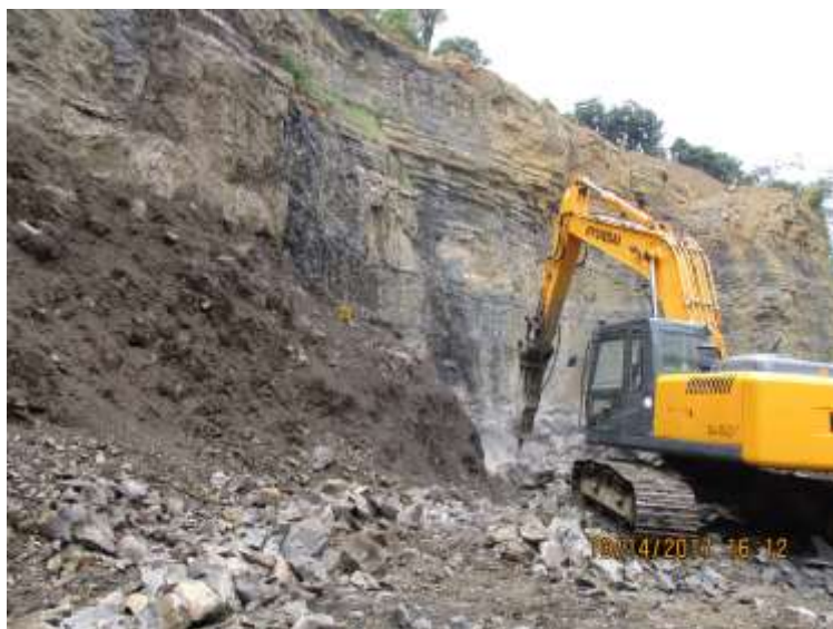
Fotografía 3.66 Sectores intervenidos para la extracción de materiales de construcción
