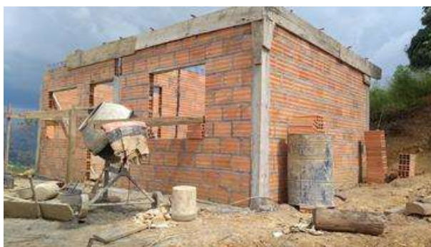
Fotografía 3.50 Vivienda en proceso de construcción en el predio La Belleza de la vereda Peñuela en Oiba
