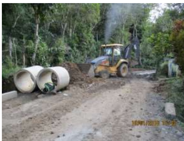
Fotografía 3.89 Paso de volquetas y adecuación de las vías terciarias de la vereda Cabras municipio de Guapotá, por la construcción de las Pequeñas Centrales Hidroeléctricas Oibita y San Bartolomé
