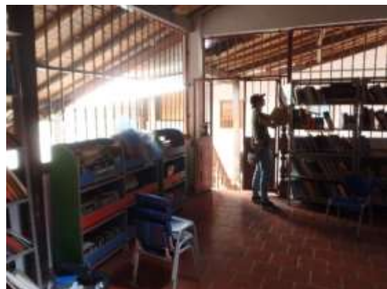
Fotografía 3.130 Espacio sin iluminación ni muebles dispuestos para consulta de libros
