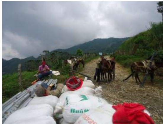
Fotografía 7.8 Material suelto a ser trasladado a sitio de torre.
