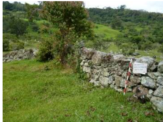
Fotografía 3.102 Parte del Muro 3(A) – 3(B), dentro de los predios de la hacienda San Eloy
