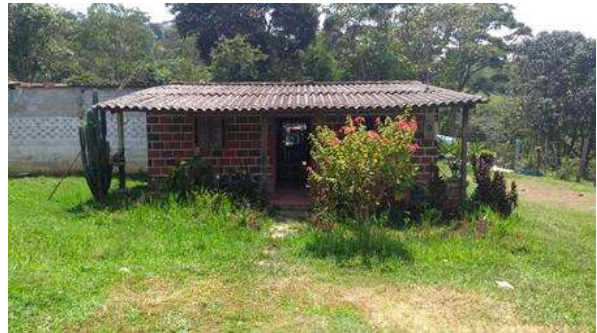
Fotografía 3.52 Vivienda del predio Villa Rosa en la vereda Peñuela de Oiba, con muros en ladrillo y cubierta en teja de barro
