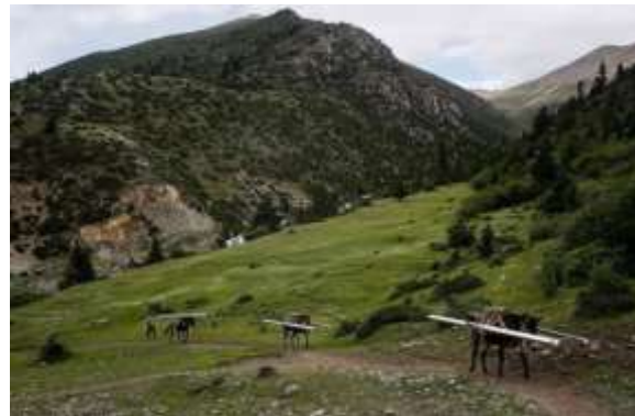
Fotografía 7.9 Traslado de material a sitio de torre.
