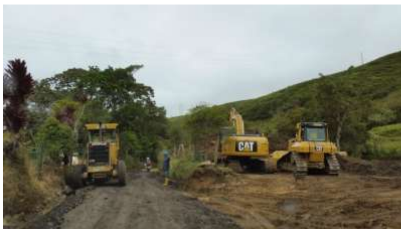
Fotografía 3.68 Mantenimiento de vías terciarias entre los municipios del área de influencia. Tramo de la vía terciaria Guapotá - Oiba
