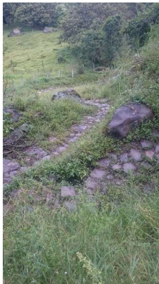
Fotografía 3.114 Tramo plano de la estructura CAMINO REAL
