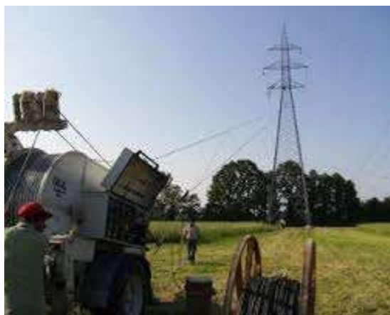
Fotografía 2.1 Plaza de tendido típica para la instalación de una línea eléctrica
