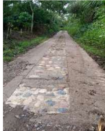
Fotografía 3.43 Vía de acceso en placa huella de la vereda Cabras
