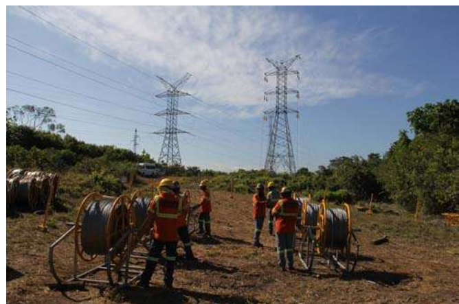
Fotografía 2.1 Plaza de tendido típica para la instalación de una línea eléctrica
