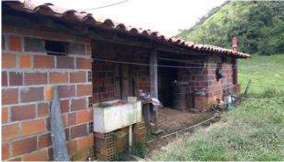
Fotografía 3.46 Vivienda construida en los materiales predominantes del AID: paredes en bloque y cubierta en teja de barro en la vereda Cabras
