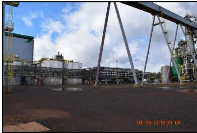
Figura 14 - Área onde será implantado o novo sistema de evaporação.
