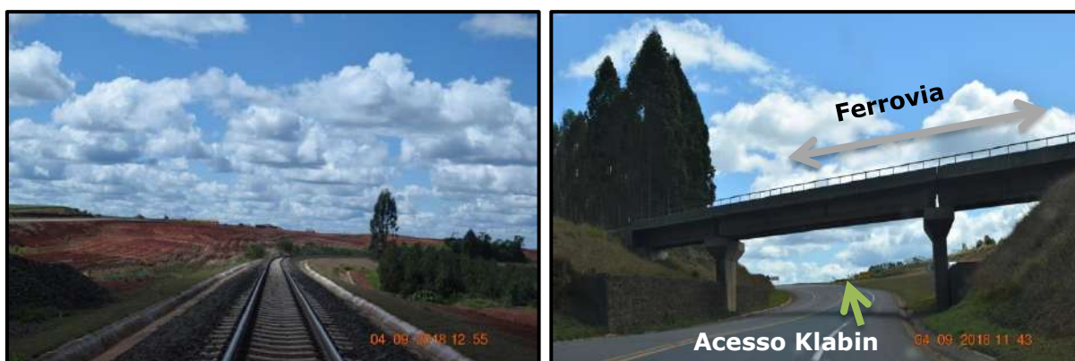
Figura 79 – Ramal ferroviário da Unidade Puma Klabin, com destaque para a passagem em desnível (viaduto com a ferrovia na parte superior).
