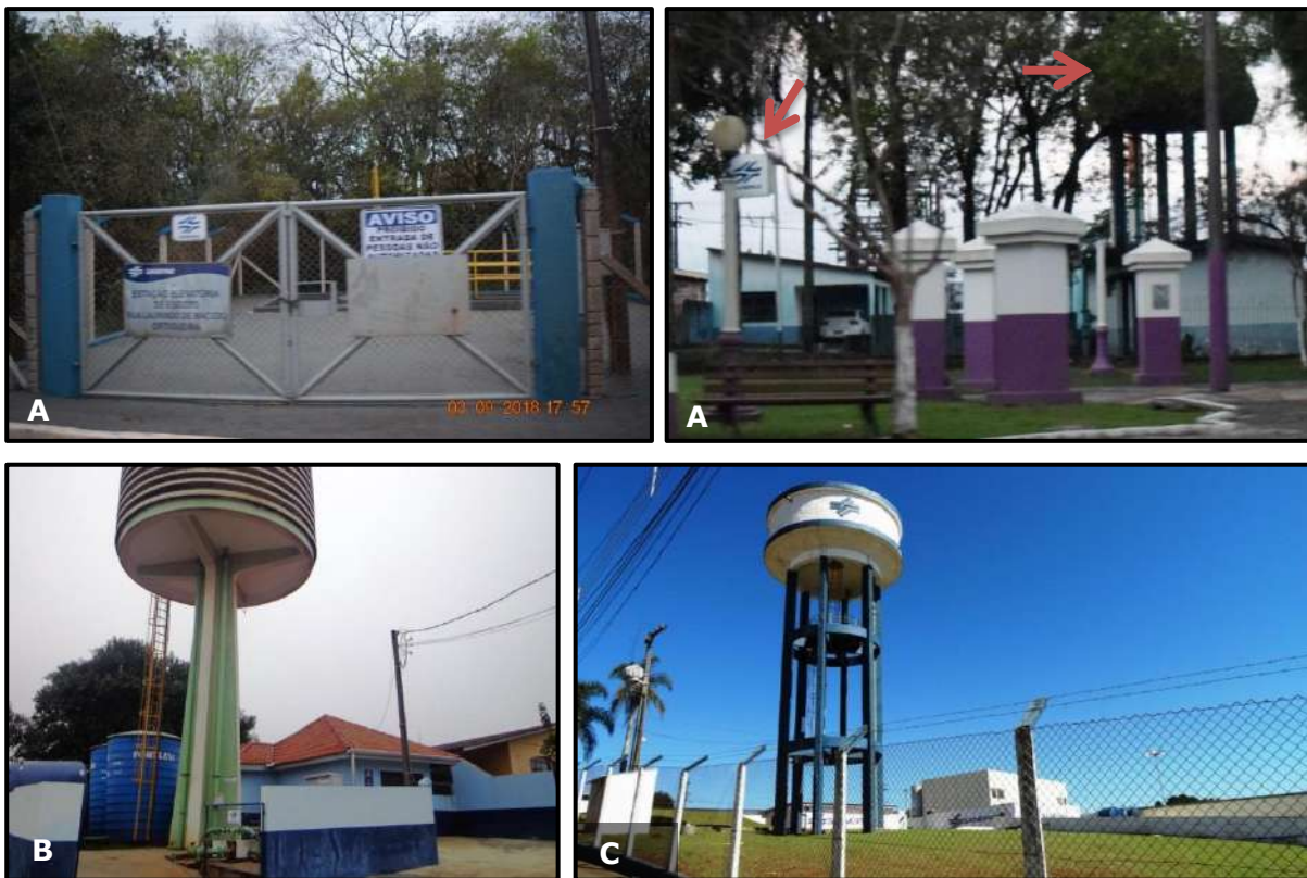
Figura 81 – Estruturas da Sanepar nos municípios da AII. (A) Ortigueira; (B) Imbaú; (C) Telêmaco Borba.
