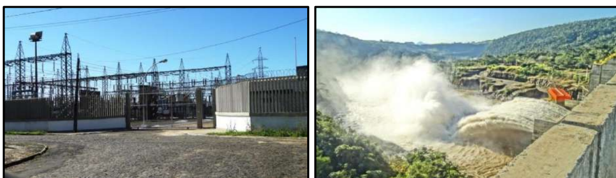
Figura 80 – Subestação de energia elétrica da COPEL em Telêmaco Borba e barramento/vertedouro da UHE Mauá na divisa entre Telêmaco Borba e Ortigueira.
