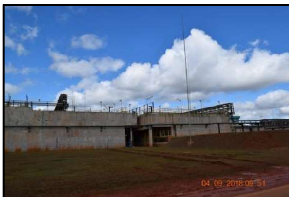
Figura 20 - Estação de tratamento de água atual.
