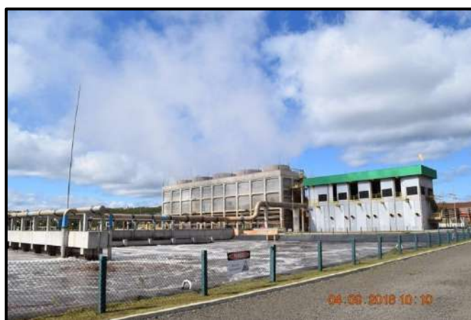
Figura 22 - Estação de tratamento de efluentes atual.
