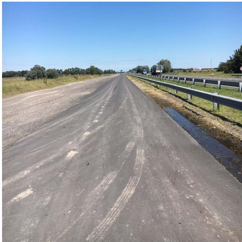
**Figura 6-4: Primera capa de asfalto finalizada**
