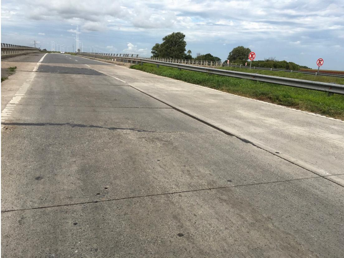
**Figura 6-3: Losas hundidas y partidas (RN9)**
