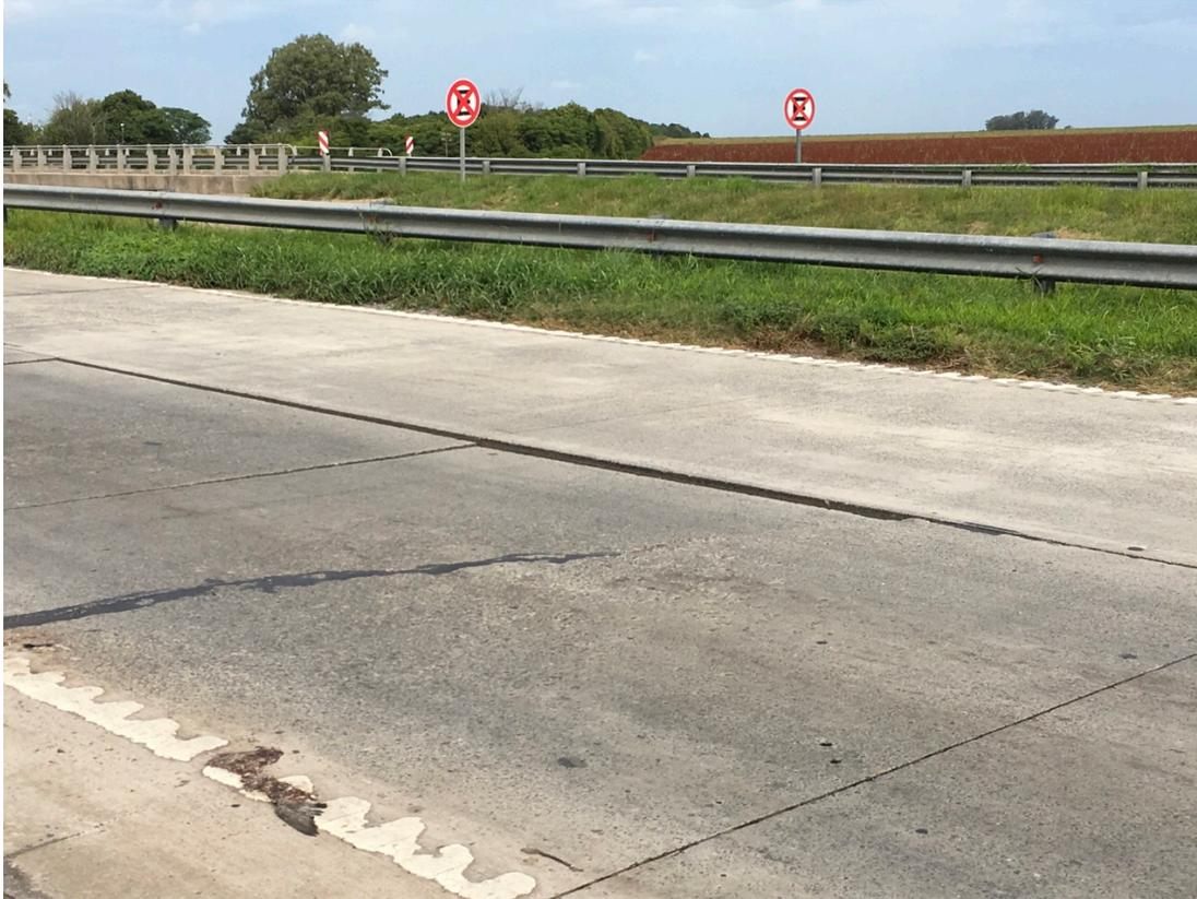
**Figura 6-4: Losas hundidas y partidas (RN9)**
