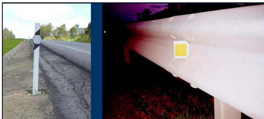
**Figura 3.3-13:** Exemplo de balizadores (Fonte: [www.poli.usp.br](http://www.poli.usp.br) - Especificação Técnica: ET-DE-L00/011)
