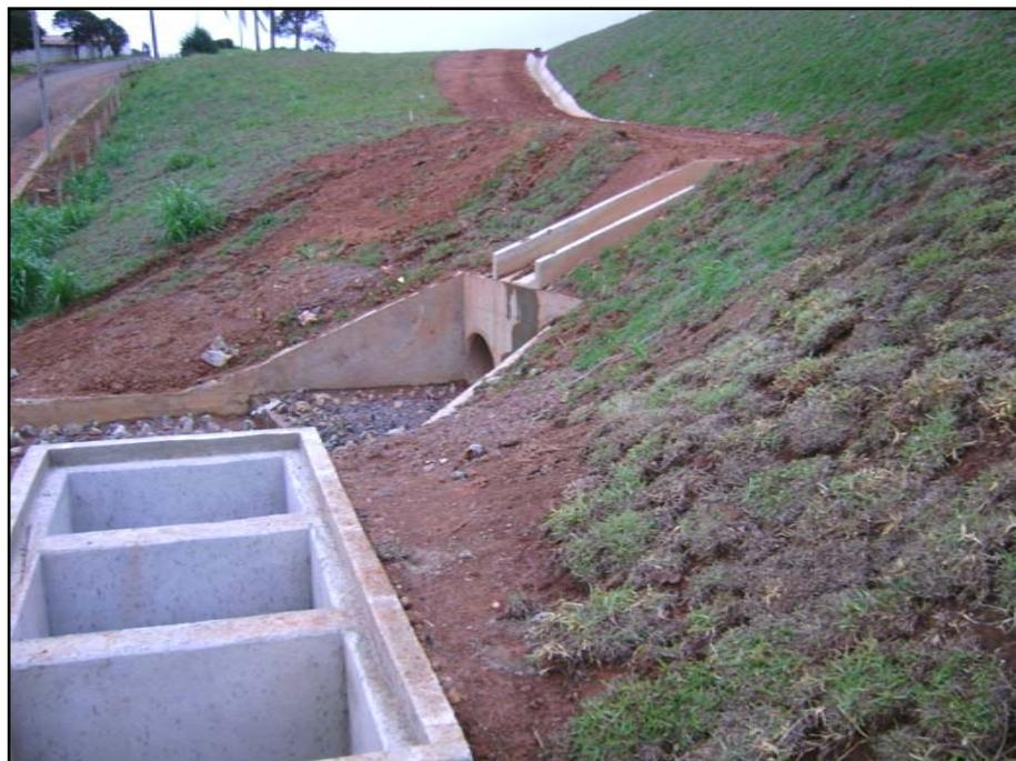
**Figura 3.4-3:** Caixa separadora com saída junto a travessia de drenagem natural sob o aterro.
