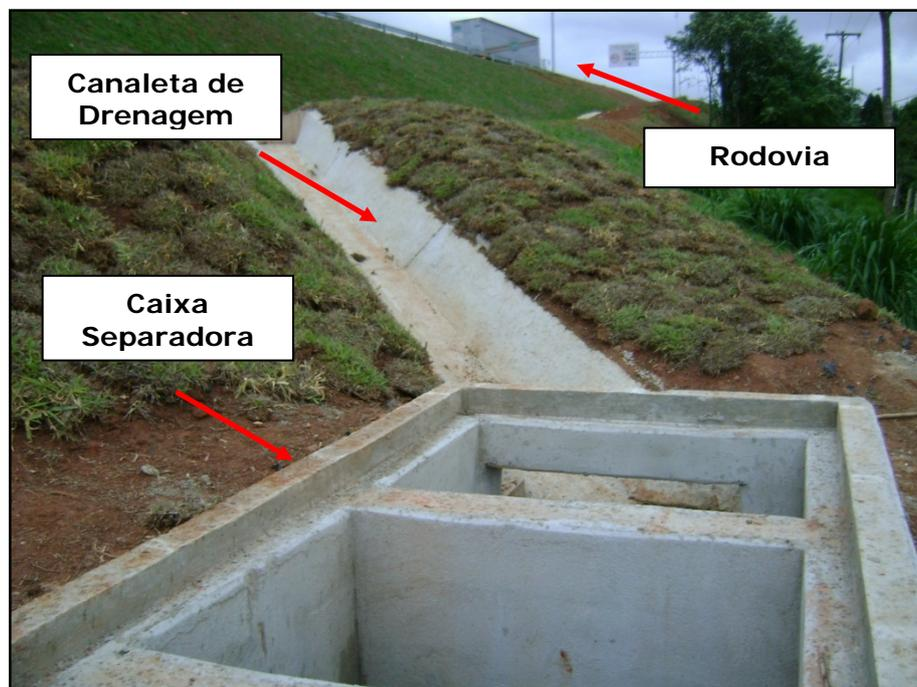
**Figura 3.4-1:** Caixa separadora ao final da canaleta de drenagem da rodovia.
