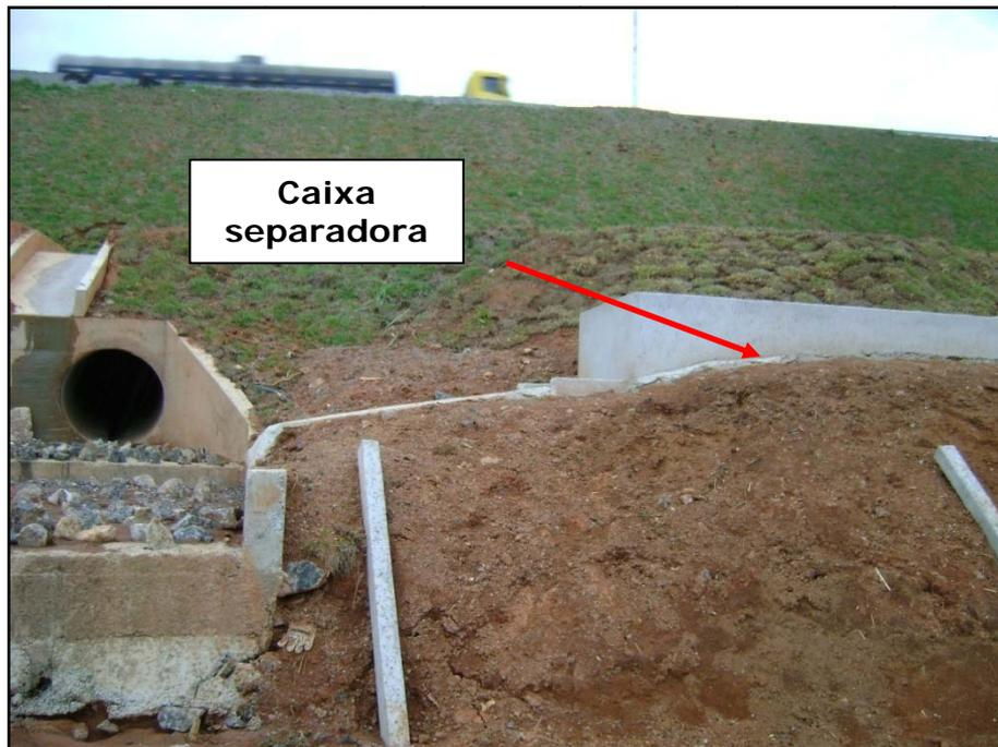
**Figura 3.4-2:** Caixa separadora junto ao sistema de drenagem, no aterro.
