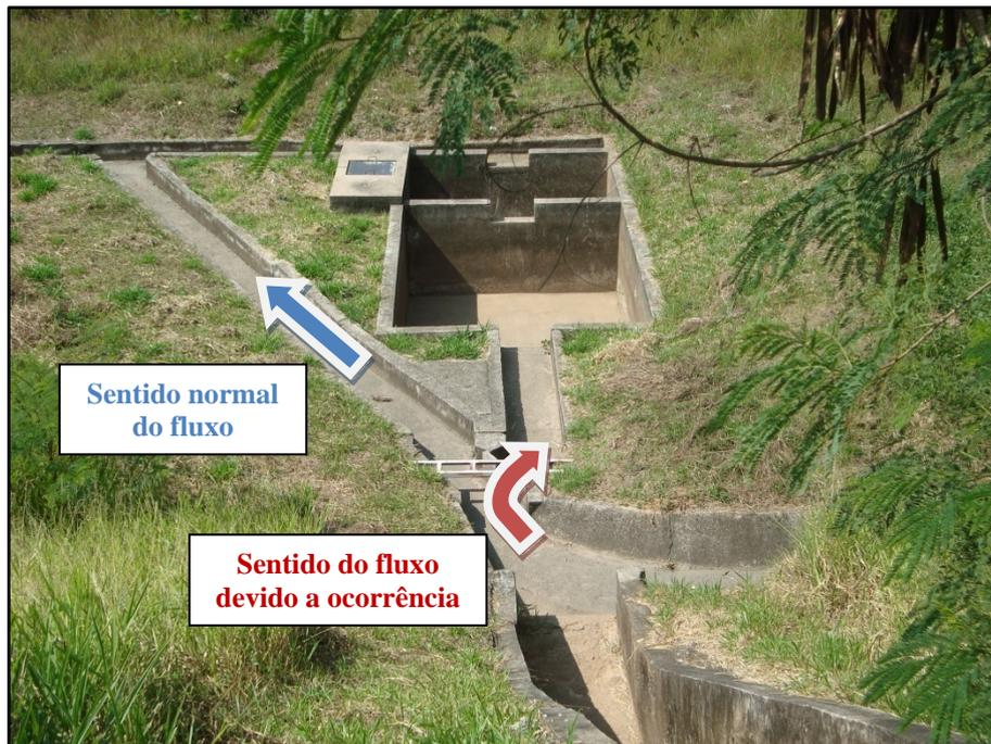
**Figura 3.4-6:** Vista da caixa de contenção junto ao sistema de drenagem de rodovia. Sistema somente é acionada em casos de vazamentos, através da mudança na direção do fluxo.
