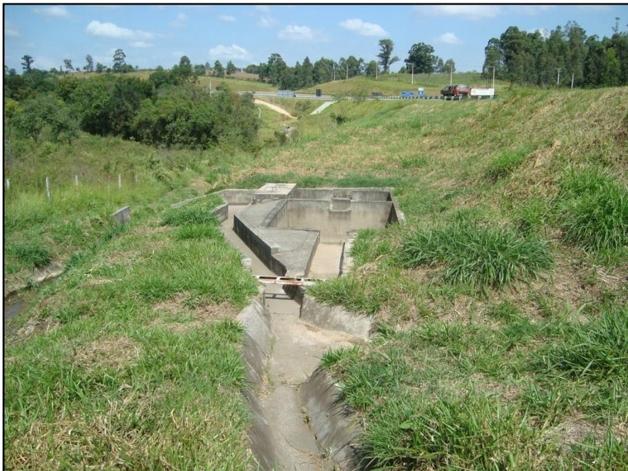
**Figura 3.4-5:** Vista geral de caixa de contenção implantada junto ao sistema de drenagem de rodovia em operação.
