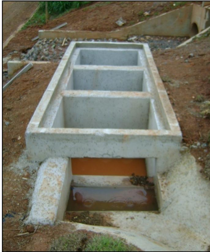
**Figura 3.4-4:** Detalhe da entrada junto a caixa separadora.
