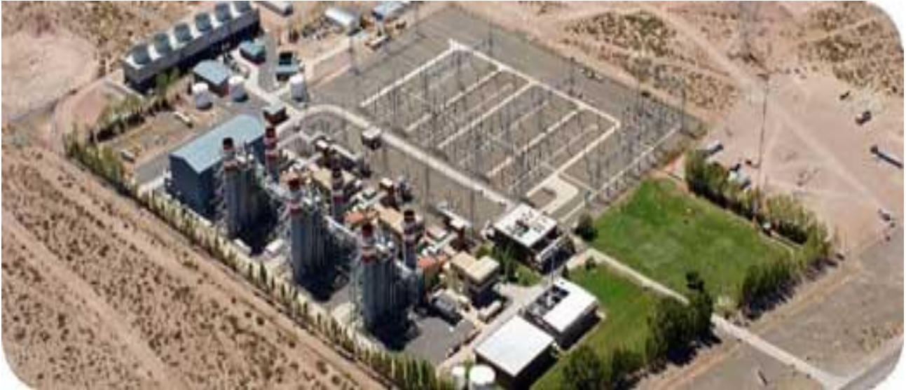
Figura Nº 3. Central de Ciclo Combinado, Loma de la Lata.
