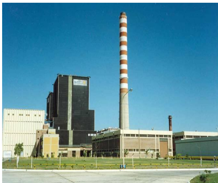
Figura Nº 2. Central Termoeléctrica Comandante Luis Piedra Buena.
