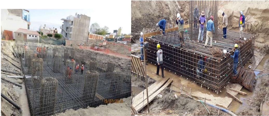
**Figura 4-17** Ejecución del hierro del encepado de zapata
