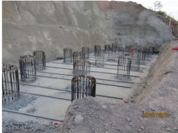
**Figura 4-16** Ejecución de zapata
